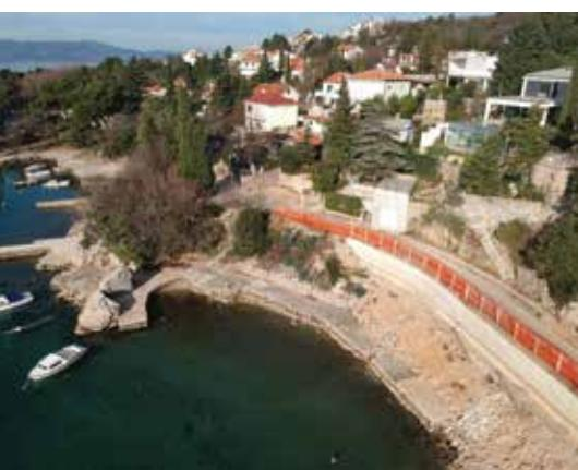
pokretljivosti, s obzirom na to da će pristup biti povezan rampama. Uz to, negdje na polovini duljine pješačke staze bit će izvedene i stepenice za prilaz. Šetnica će biti ukupne duljine 257 metara. Na samome svom početku kružno će zaobići postojeću obalnu stijenu i spustiti se u podnožje zida. Na mjestima gdje postoji mogućnost pada s visine veće od jednog metra bit će postavljena zaštitna metalna ograda visine jednog metra.
