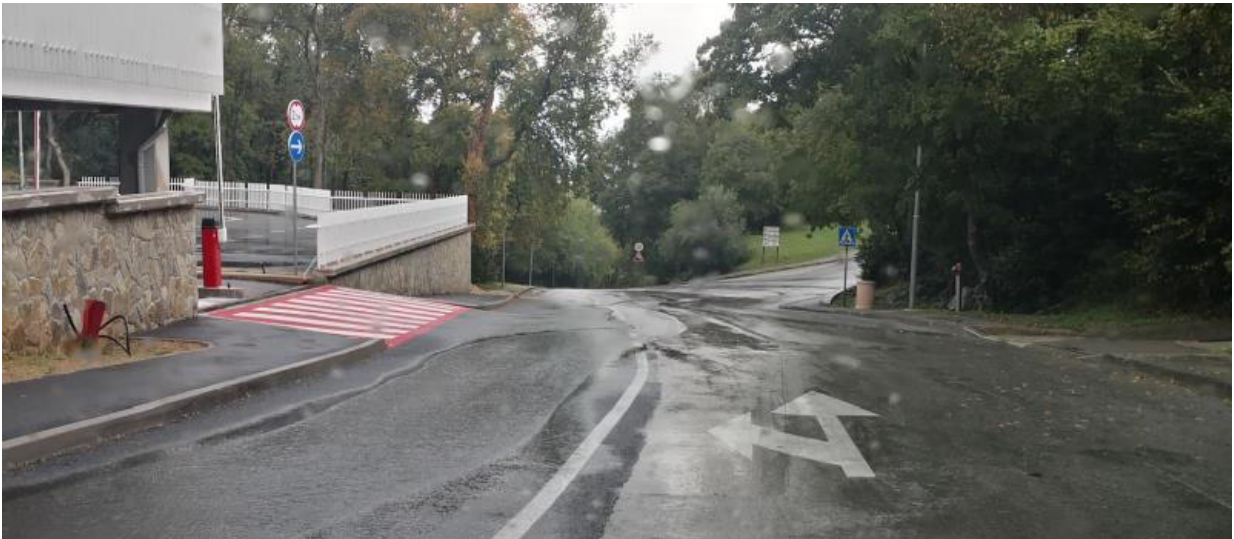
Slika 5 - pogled na ulicu Podorišina kod ulaza na treću razinu parkirališta
