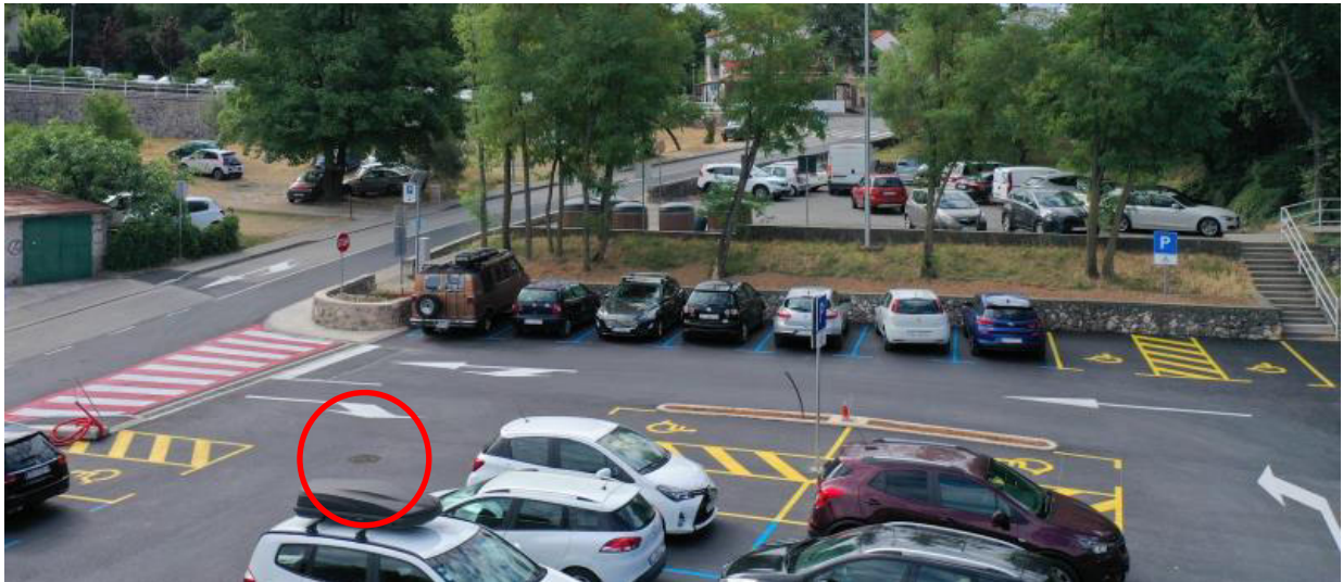
Slika 3 - pogled s druge razine parkirišta prema prvoj razini i pogled na postojeće okno RO-4 na koje se priključuje kolektor 1 (crveno)
